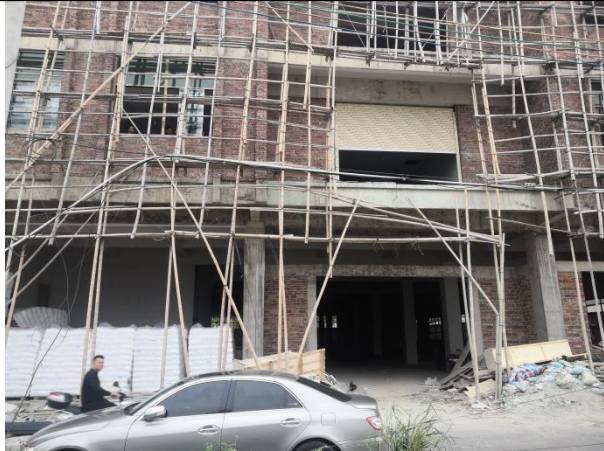
北面：在建厂房
