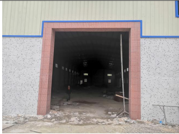
南面：隔空地为空厂房
