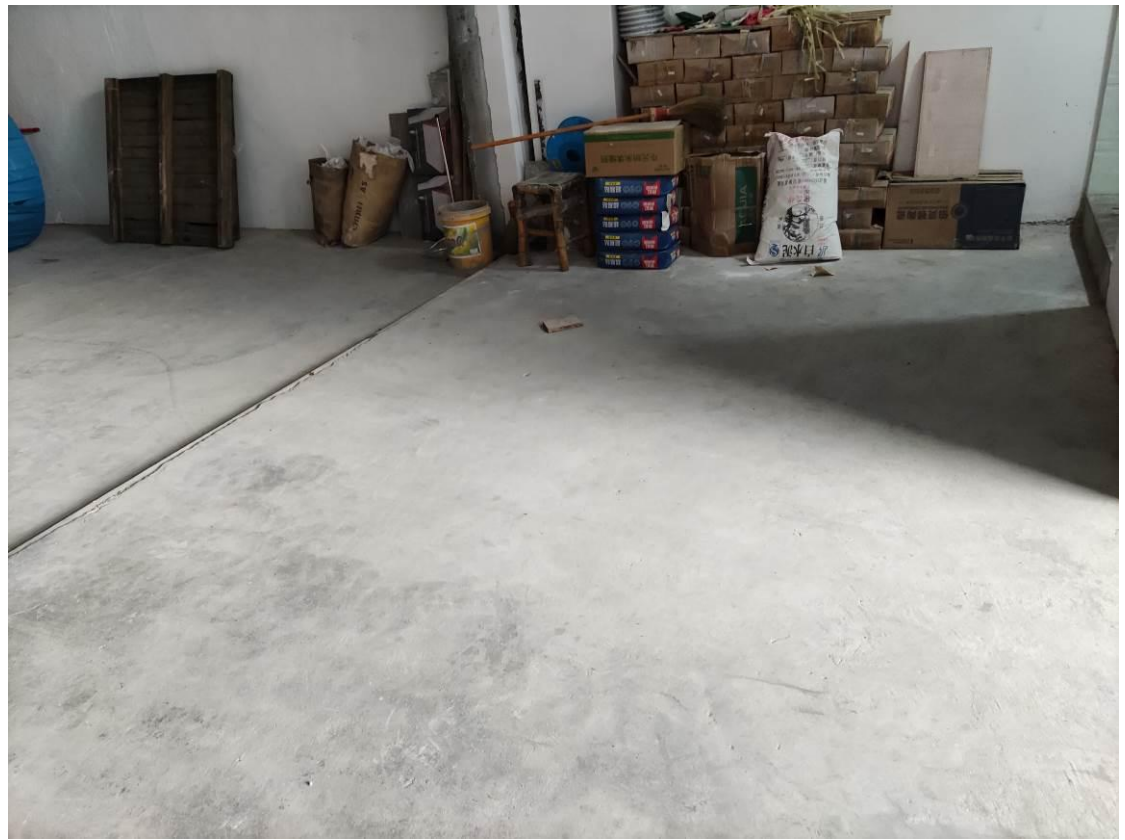
厂内（硬化地面）
