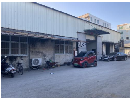
项目西侧印刷厂
